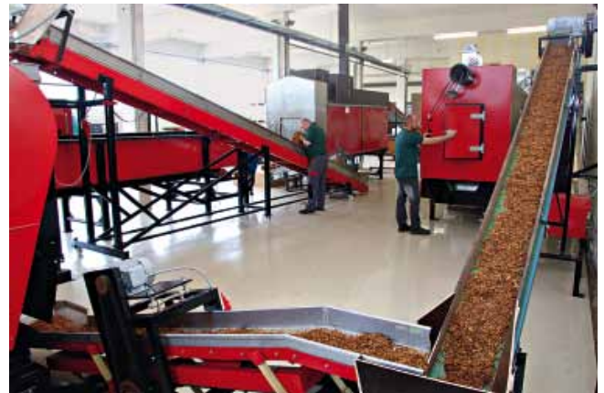
Die Tabakschneidestraße in der DTM-Produktionshalle
